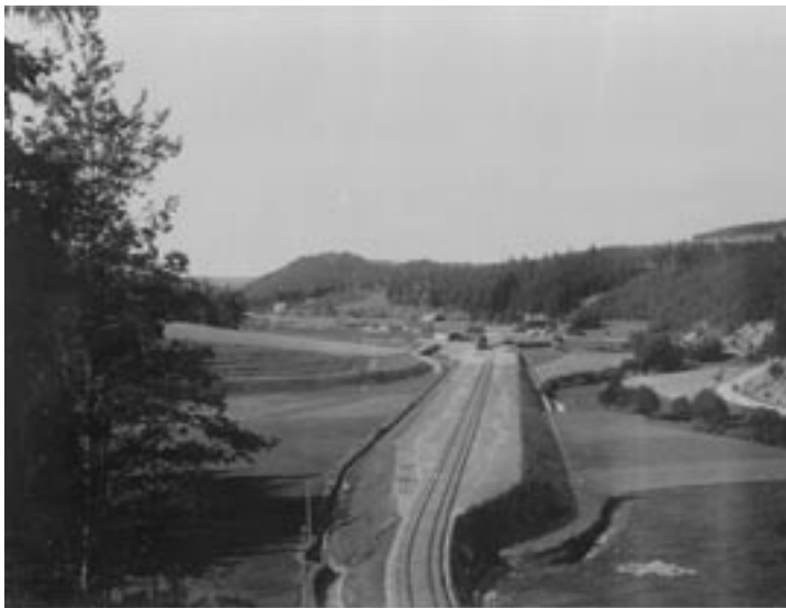
Těleso nové tratě v Rožně.
